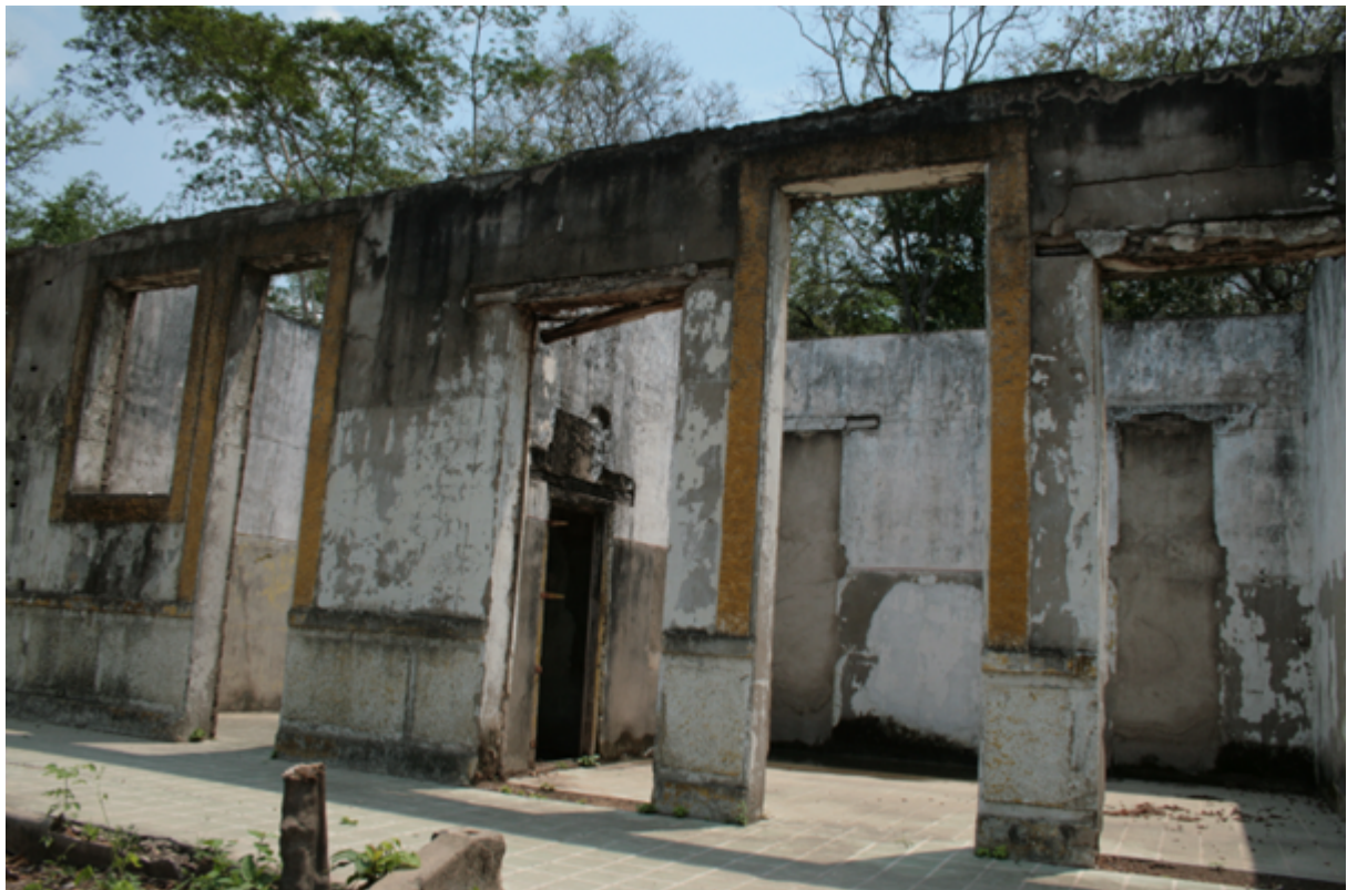
Figura 5 – Fachada principal de la Casa de la Desinfección de Agua de Dios
