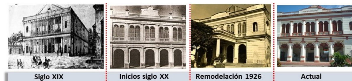
Figura 8 – Evolución constructiva del Teatro Principal de Camagüey
