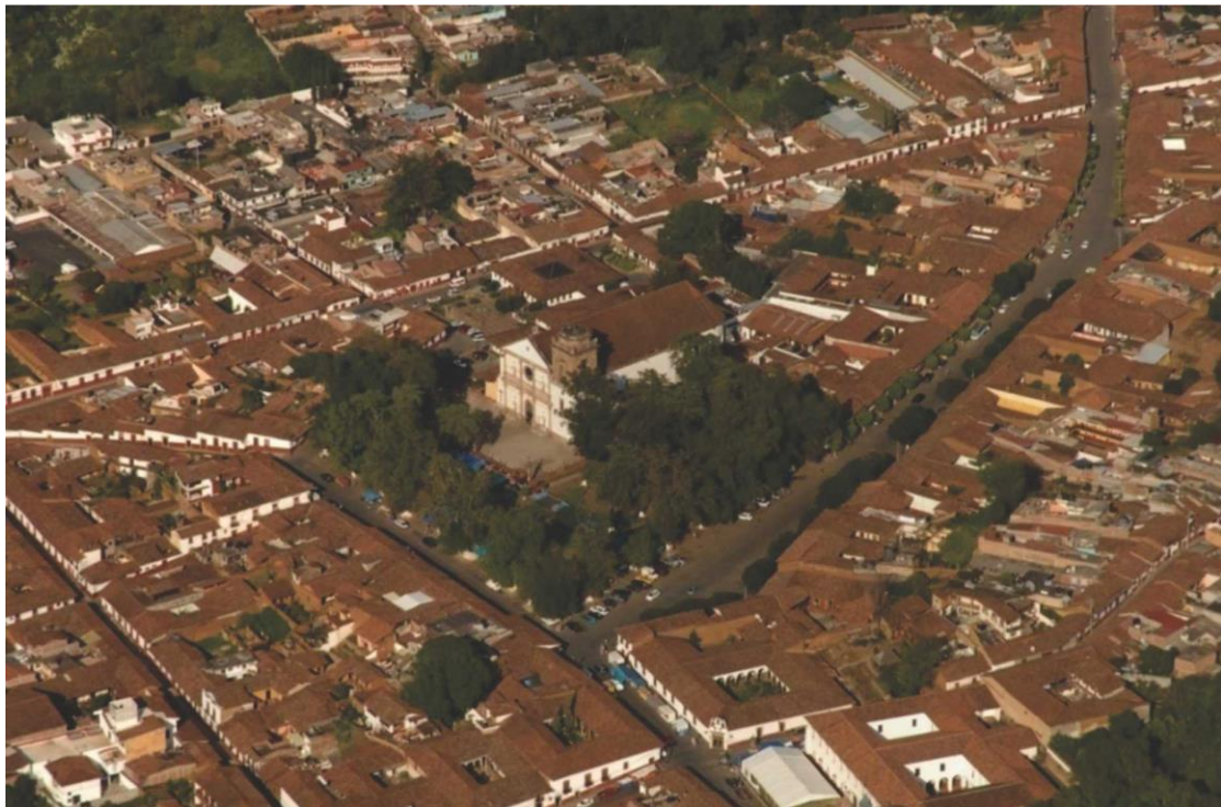
Figura 12 – “Vista aérea del barrio Fuerte de Pátzcuaro”
