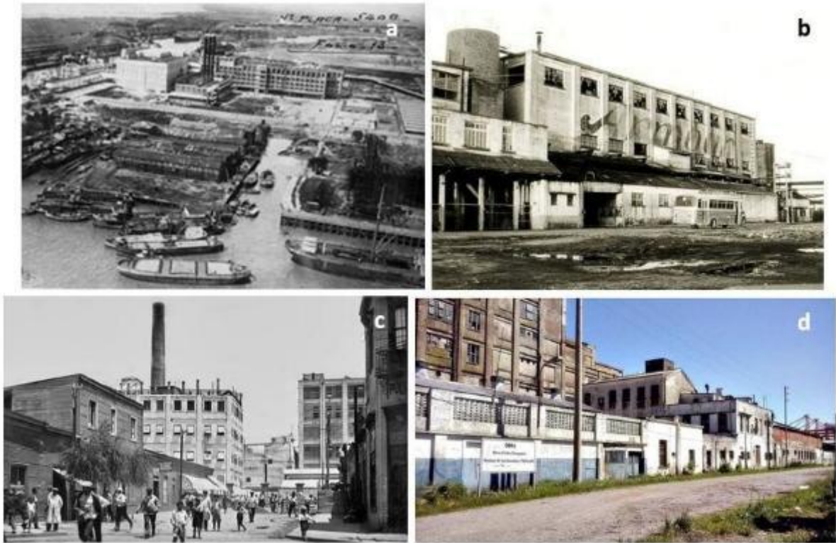
a- Frigorífico Anglo en Dock Sud, 1927; b- Frigorífico Armour, década de 1930; c y d- Frigorífico Swift en la década del 30 y en la actualidad.
