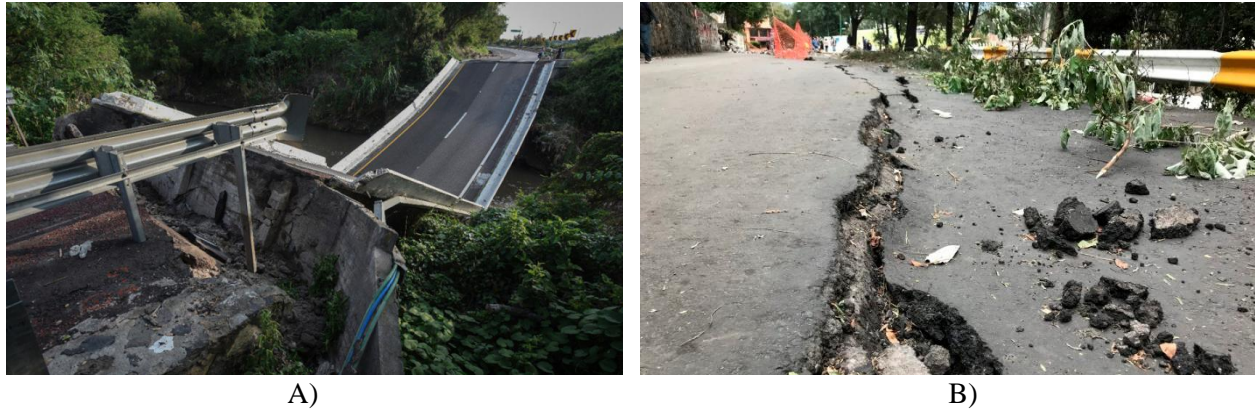
Figura 12. Daños en la infraestructura vial: A) Colapso de un puente en la autopista México-Acapulco. Fuente: El Universal. Créditos: Policía Federal y B) Agrietamiento en la carretera Xochimilco-Tulyehualco. Fuente: Quadratín México
