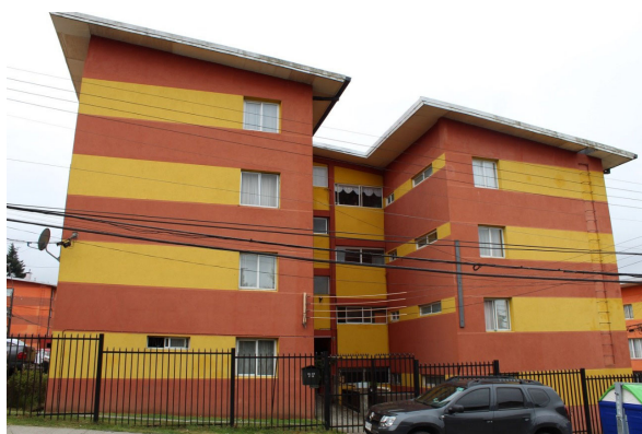
Figura 4. Las techumbres, las bajadas de aguas lluvias y fachadas fueron remodeladas gracias a fondos gubernamentales del Minvu durante el 2015
