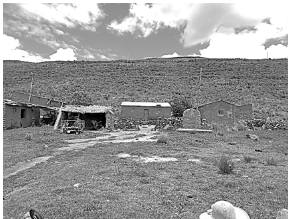
Figura 8. Distribución espacial de la arquitectura vernácula P_{04} (-15.715236, -70.199692), con construcciones de adobes y con cobertura de lámina metálica acanalada
