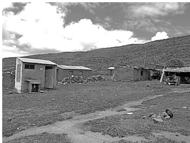
Figura 7. Distribución espacial de la arquitectura vernácula P_{03} (-15.637741, -70.174553), con construcciones de adobes y con cobertura de lámina metálica acanalada
