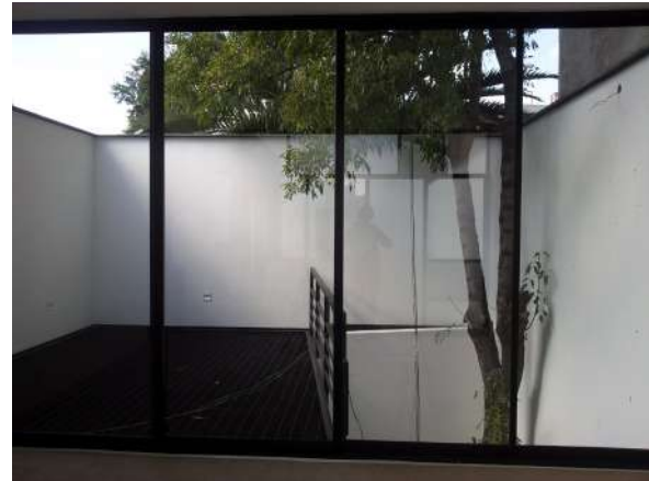
Figura 9. Vista de la terraza en rejilla metálica en 2012
