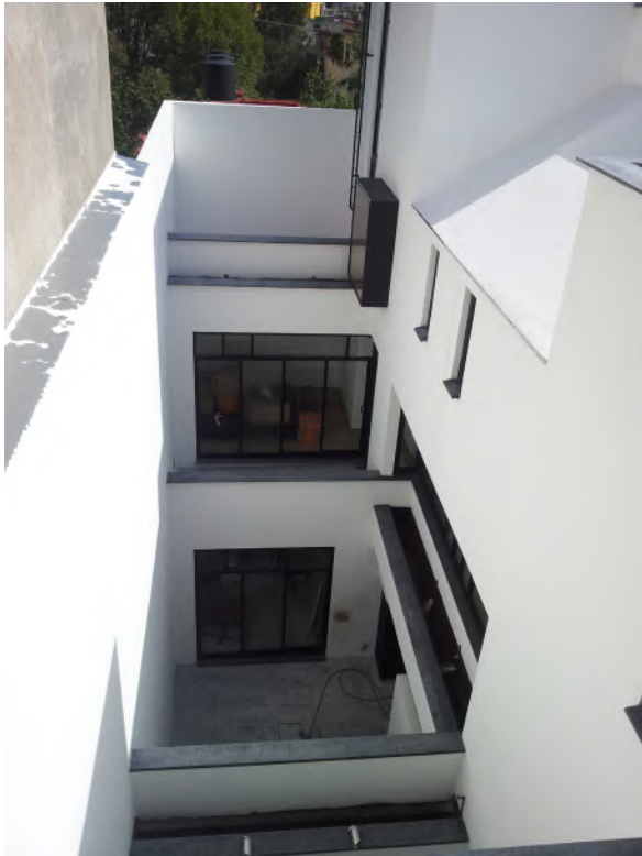
Figura 8. Vista de la obra casi terminada en 2012. Se observa la sucesión de patios y el trabajo de los volúmenes para dejar pasar la luz hasta la parte más baja
