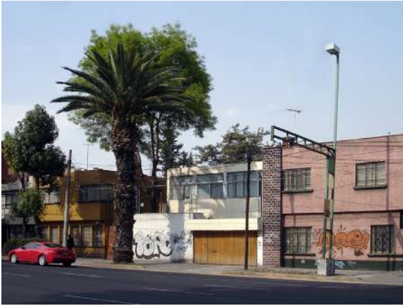
Figura 3. Vista de la casa antes de su transformación en 2010. Se observa la vialidad y el entorno deteriorado con grafitis
