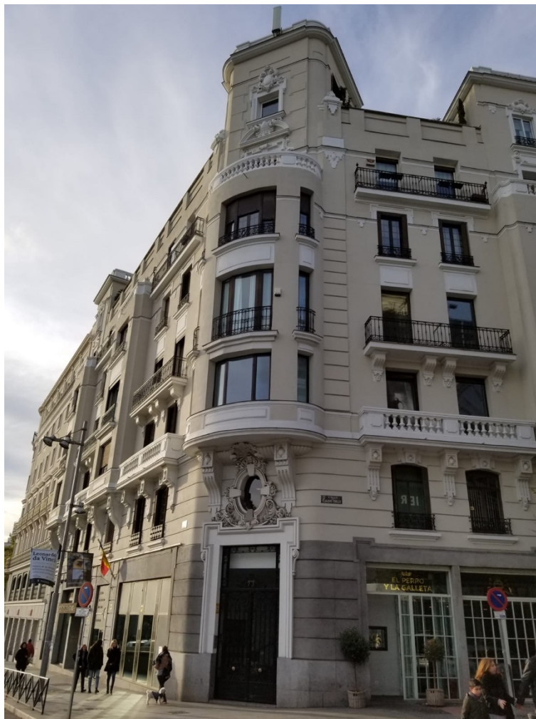
Figura 1 Edificio neobarroco en las confluencias de las calles de Alcalá y Claudio Coello de Madrid (1920), arquitecto José Yarnoz Larrosa. Fuente: elaboración propia
