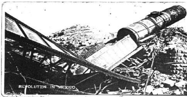
Deterioro de la red férrea del Chihuahua al Pacífico durante la Revolución. (Foto ofrecida por un ferrocarrilero jubilado.)
