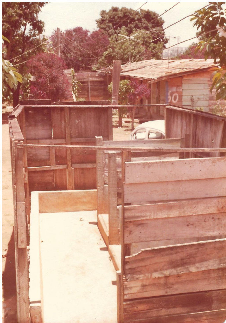
Imagen 4. Baño de campamento obrero, Villa Planalto.
