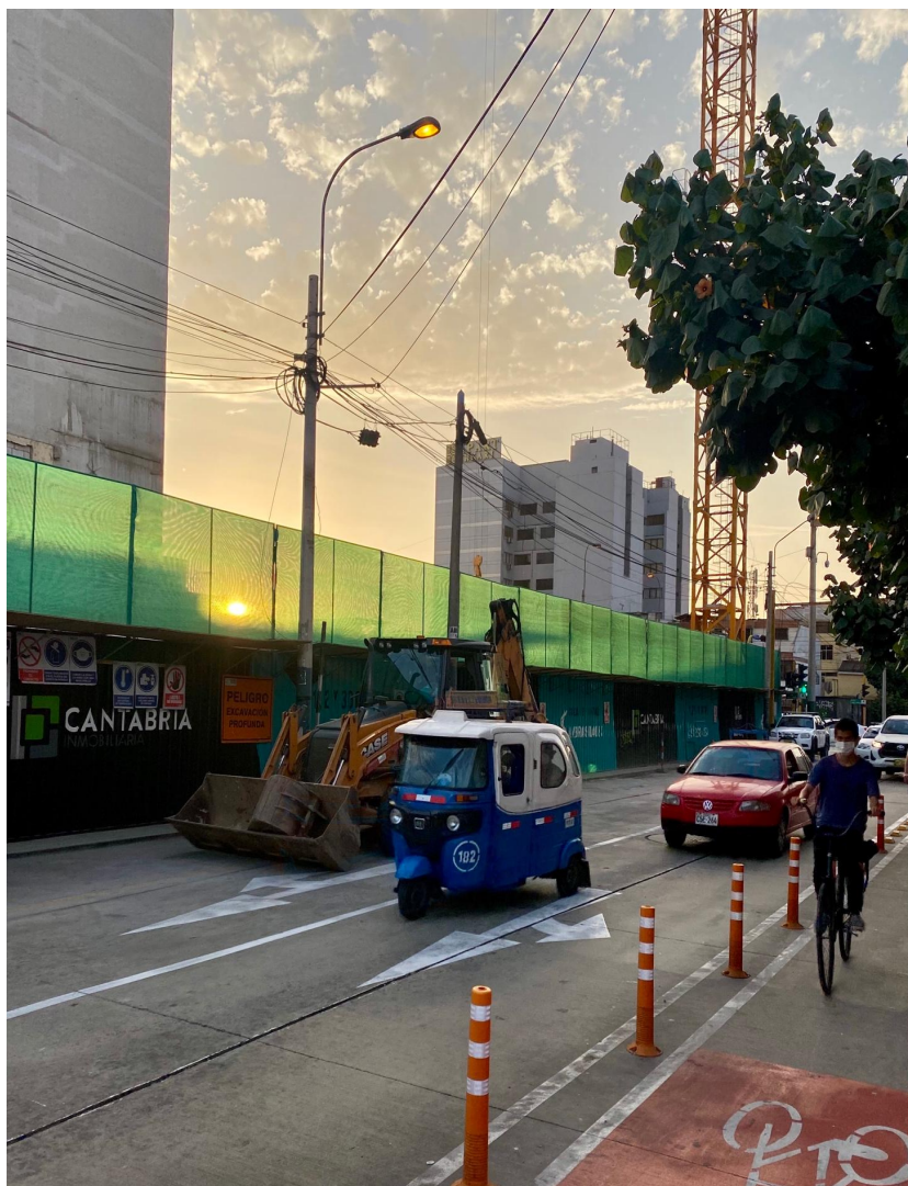
Foto 5. Magdalena en construcción
