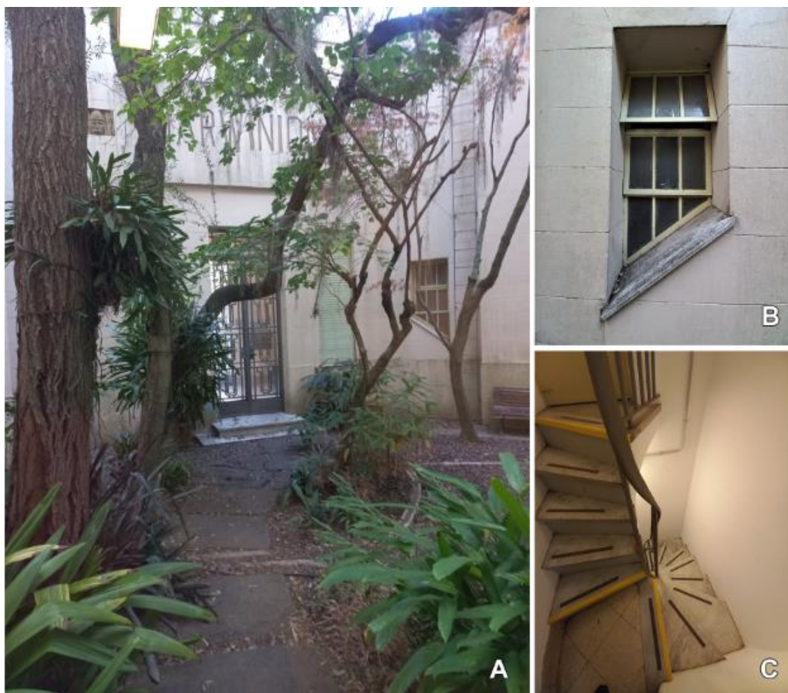
Fig. 11. Instituto Darwinion. A, vista del patio interno. B, detalle de ventana de escalera esquinera. C, escalera esquinera que conduce al mezzanino de la biblioteca. Figura en color en la versión en línea http://www.ojs.darwin.edu.ar/index.php/darwiniana/article/view/1055/1262
