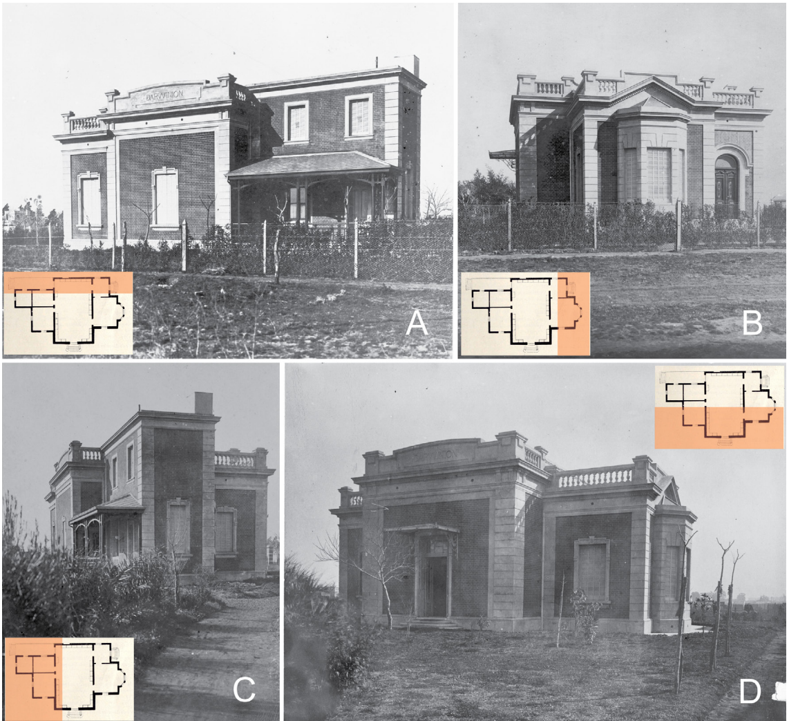
Fig. 4. El Darwinion de Villa Progreso. Vistas del Edificio alrededor de 1910 (la fachada fotografiada se indica en el esquema de la planta con una franja de color; el esquema de la planta mantiene la misma orientación que en la Fig. 1A y Fig.3). A, fachada noroeste sobre la calle Progreso, nótese el letrero “Darwinion” sobre la ventana central. Las ventanas sobre la galería probablemente corresponden a un cuarto de huéspedes. B, fachada noreste sobre la calle Heredia. C, fachada sudoeste hacia el jardín, nótese la galería. D, fachada sudeste hacia la quinta familiar de Christian Hero Hicken; nótese la entrada principal del museo del Instituto de Botánica Darwinion, y el letrero en su parte superior. En las fachadas A y B se observa la falta de un portón hacia la calle. Fotos: Archivo Instituto de Botánica Darwinion.
