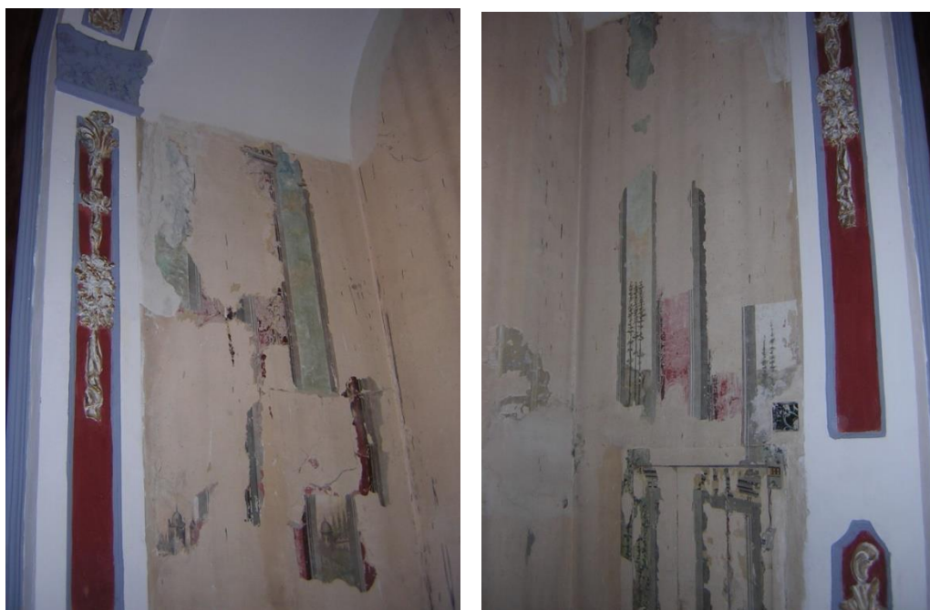
Figs. 8 y 9. Vista general de las catas realizadas en ambas paredes laterales de la hornacina-camarín. Capilla de las Ánimas . Iglesia de San Juan Bautista. Málaga. [Autor].
