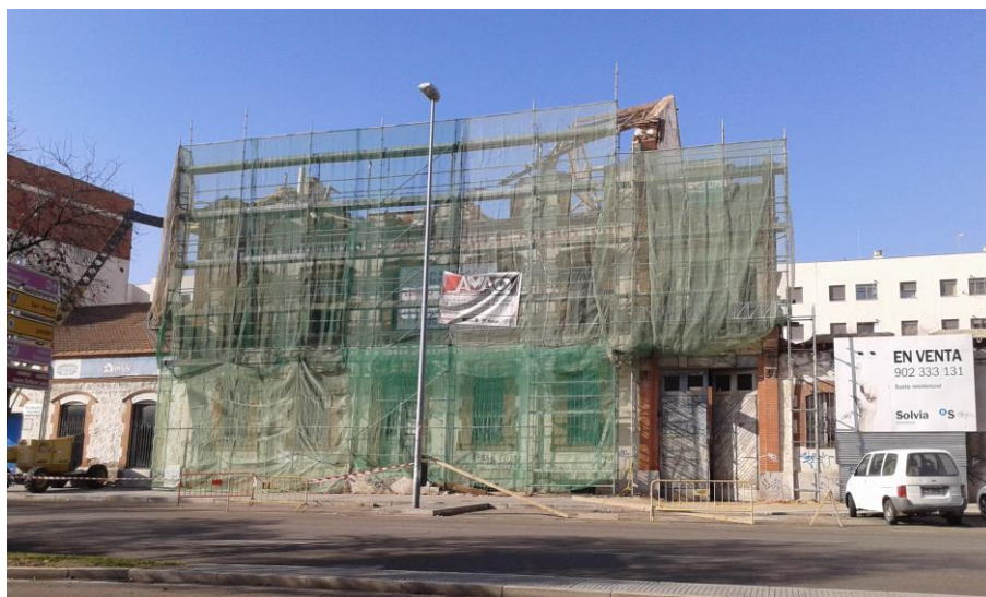
Fig. 4. Proceso inicial de demolición de La Panera Social, Zamora. (Gregorio Pérez Arribas, 1921). Foto: RAG-L.
