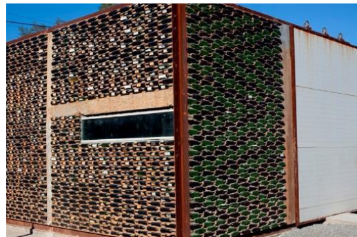
Fig.6. Madera y botellas de vidrio recicladas en la Estación de Oficios. Fuente: Fotografía de Javier Zayeck, TAC.
