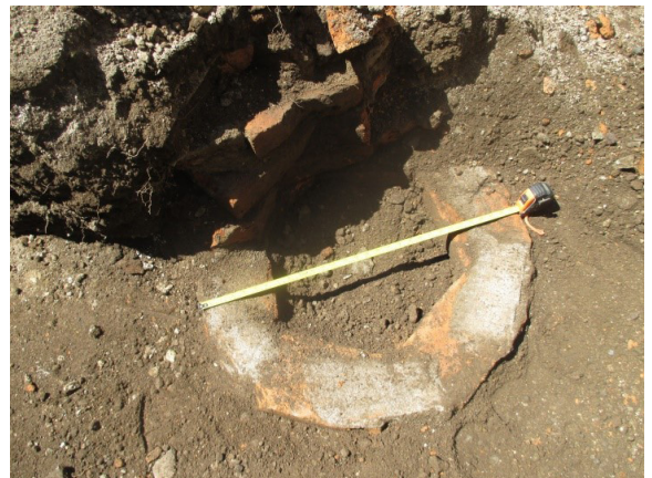
Figura 31. Base de un registro de drenaje de forma hexagonal, elaborado con tabique rojo.
