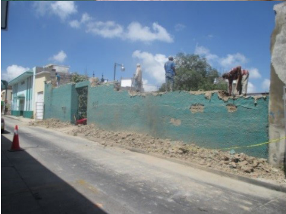
Figuras 20 y 21. Muro con acabado de cal arena, pintado. Se encontraba en proceso de demolición. Pertenecía a la fachada sur del predio de Miguel Hidalgo No. 107 Ote. Fuente: Jiménez (2006-2007).
