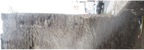
Figura 19. El muro de adobe de la fachada principal mide 4.72 m de altura, y presenta un guardapolvo de 0.58 m de alto, con un recubrimiento de ladrillos. Sus dimensiones son 0.26 x 0.15 x 0.05 m. El muro presenta un aplinado final de (cal-arena), y se encuentra pintado. Fuente: Jiménez (2006-2007).
