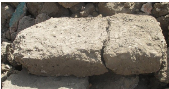
Figura 15. Ejemplo de un Adobe. Sus proporciones son: 0.53 x 0.28 x 0.10 m Fuente: Jiménez (2006-2007).
