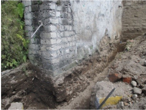
Figura 27. Modificación del muro Sur de la casa Norte en su lado Noreste, con la construcción de un cuarto de baño hecho con tabicón y castillos de concreto.
