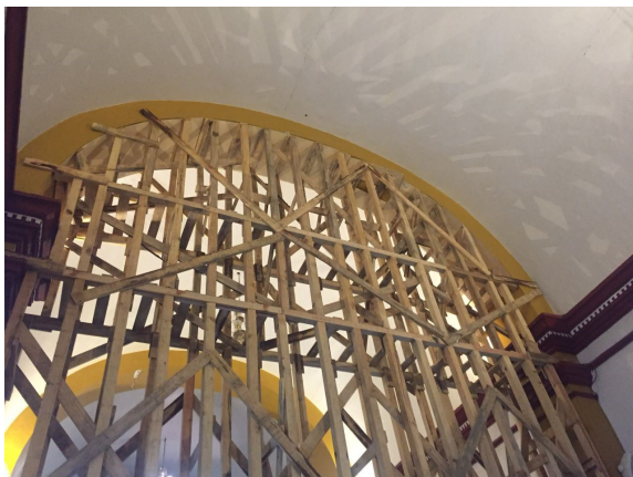
Fig.17 Fachada principal. Fig. 18. Apuntalamiento en arco fajón de la nave principal del Templo de San Sebastián Mártir. Localidad: San Sebastián Tutla. Municipio: San Sebastián Tutla. (Julio-2018) PTMX.
