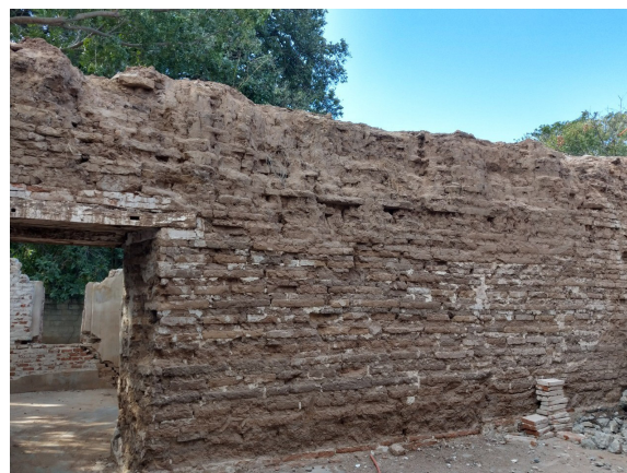
Fig. 24 Fachada principal del Antiguo Palacio. Fig. 25. Muros de la fachada posterior del Antiguo Palacio donde se observa la fábrica de los muros a base de mampostería de tierra. (Enero de 2021). TAMSQ.
