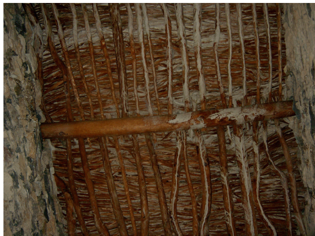
Figura 7. Detalle del techo de una vivienda vernácula rifeña (fotografía de la autora, 2010).
