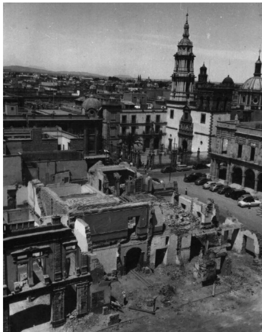
Figura 11: Demolición para construir la Plaza de Los Laureles, proyecto de Cruz de Plazas, 1952. Plans, https://www.plans.com.mx/guadalajara-antigua/
