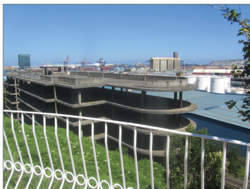
Figura 5. Vista del Puerto de Bilbao desde el Paseo de la Sardinera (2020).
