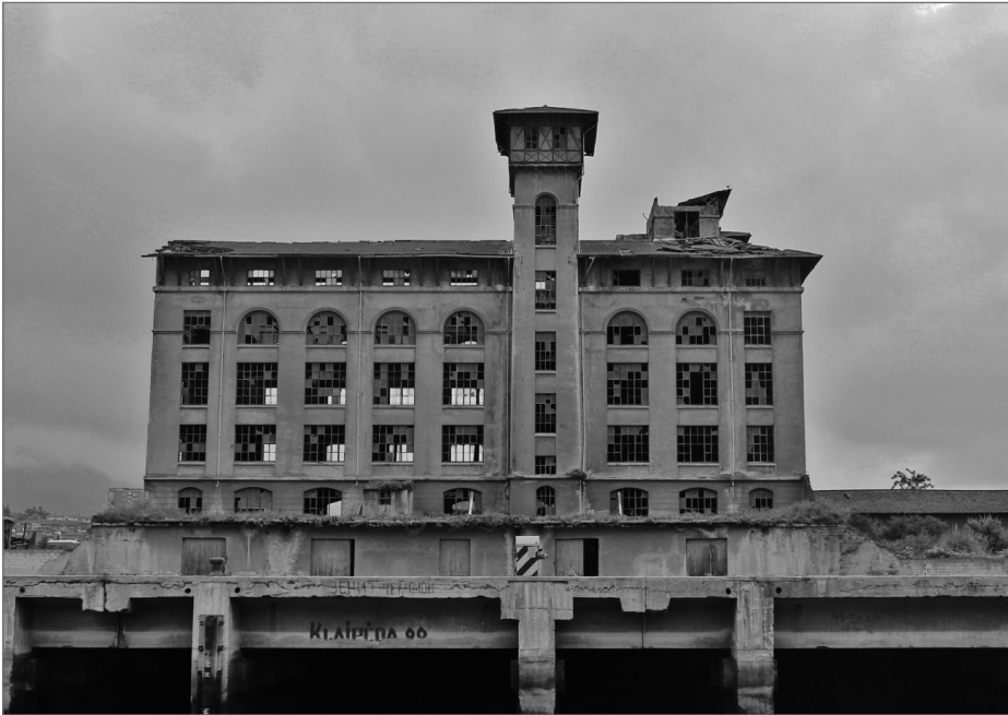
Estado actual de abandono de la harinera Grandes Molinos Vascos
