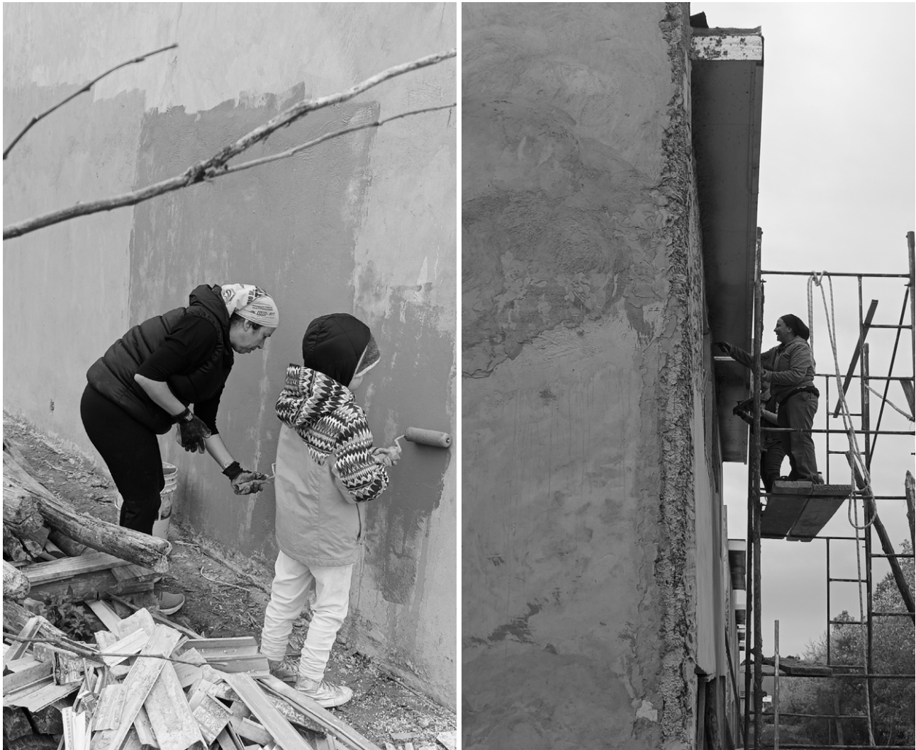
FIGURA 1 | Cooperativistas mujeres en obra. Fuente: elaboración propia.
