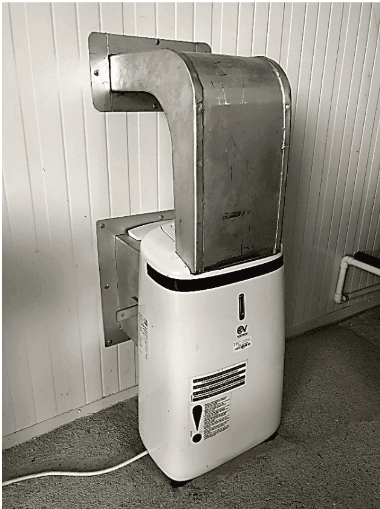
Figura 5 Instalación del deshumidificador portátil Deumido M20
