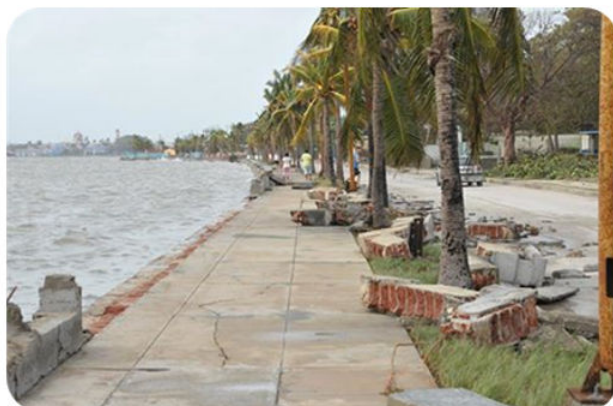
Figura 12. Afectaciones producidas en Punta Gorda debido a la fuerza del oleaje, e inundaciones por las lluvias intensas.
