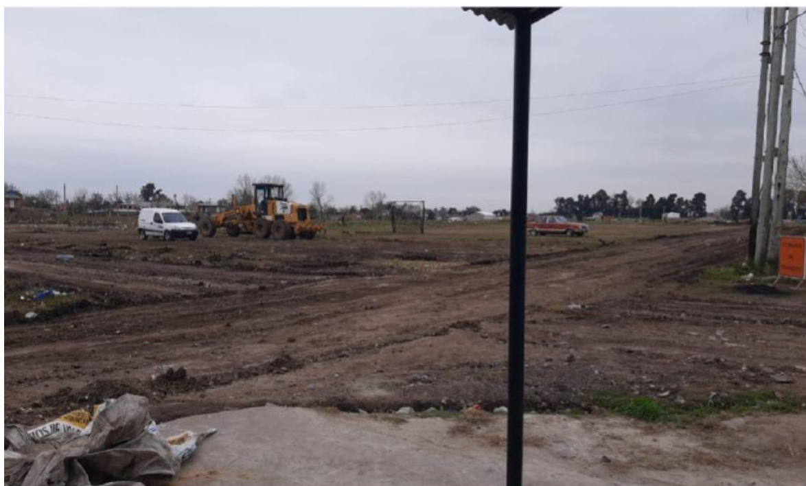
Figura 1 – Fotografía enviada por uno de los adolescentes del barrio cuando comenzó la obra (23 jun. 21)
