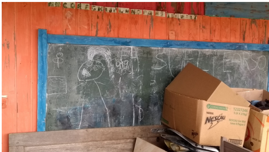
Figura 2 – Parede externa da Creche Filhos da Luta
