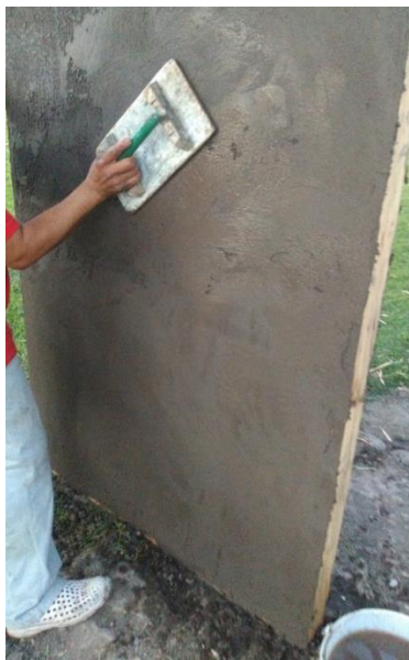
Figura 10. Vista del módulo del bahareque ya terminado. Fuente: Elaboración propia (2018).
