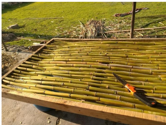
Figura 8. Vista del entramado de carrizo. Fuente: Elaboración propia (2018).
