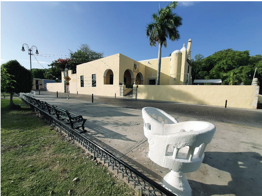
Figura 10. El parque y la ermita de Santa Isabel, así como la sección de calle adoquinada existente entre ambos elementos, en una foto de 2019. También pueden apreciarse el confidente y la banca con reglas de madera características de los espacios públicos en la Zona de Monumentos Históricos de la ciudad de Mérida.
