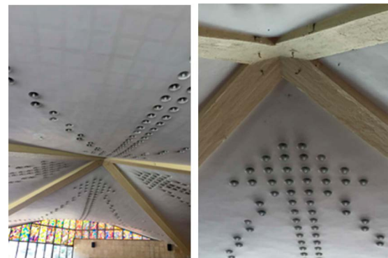
Figura 16a. Vista interior de la construcción de los mantos de forma paraboloi-de hiperbólica y de los nervios que los soportan. Fotografías: Luis Castro, Palafoxianum , junio 1961.
