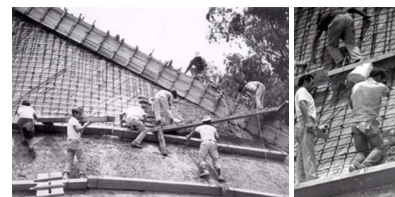
Figura 3. Encofrado y colado de la iglesia de San Antonio de Padua, colonia Xotepingo, Coyoacán. Proyecto: arquitectos Carlos González Lobo y Leonardo Vilchis Plata; diseño estructural: Juan Antonio Tonda. Fuente: Novena Conferencia Ciclo de Seminarios Virtuales. Arquitectura Religiosa, 19 octubre 2020.
