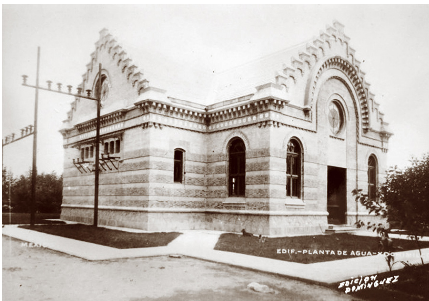
Figura 6. Edificio planta de agua Xochimilco, circa 1920.
