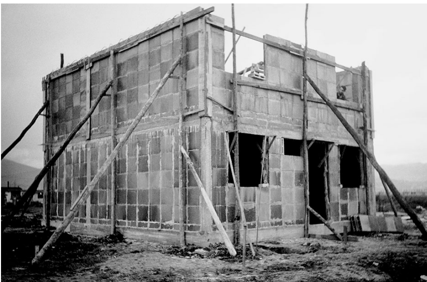
Figura 3. Vista de la casa experimental para la urbanización Torcoroma, una vez terminada. Fuente: René Eyhéralde, "Proyecto casa experimental ict. Informe de progreso No. 2", mecanografiado, AHUNC-FC, caja 31, 1954.
