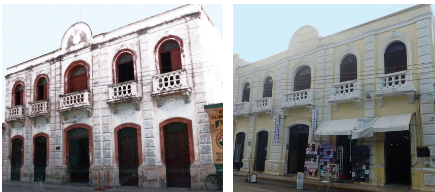
Figura 10. Izquierda. Local de “Maniobras Marítimas de Progreso, S.C.L.”, s/f. Fuente: Archivo Romero Frías Bobadilla. Derecha. El local en la actualidad. Fuente: Archivo fotográfico de la autora, 2023.
