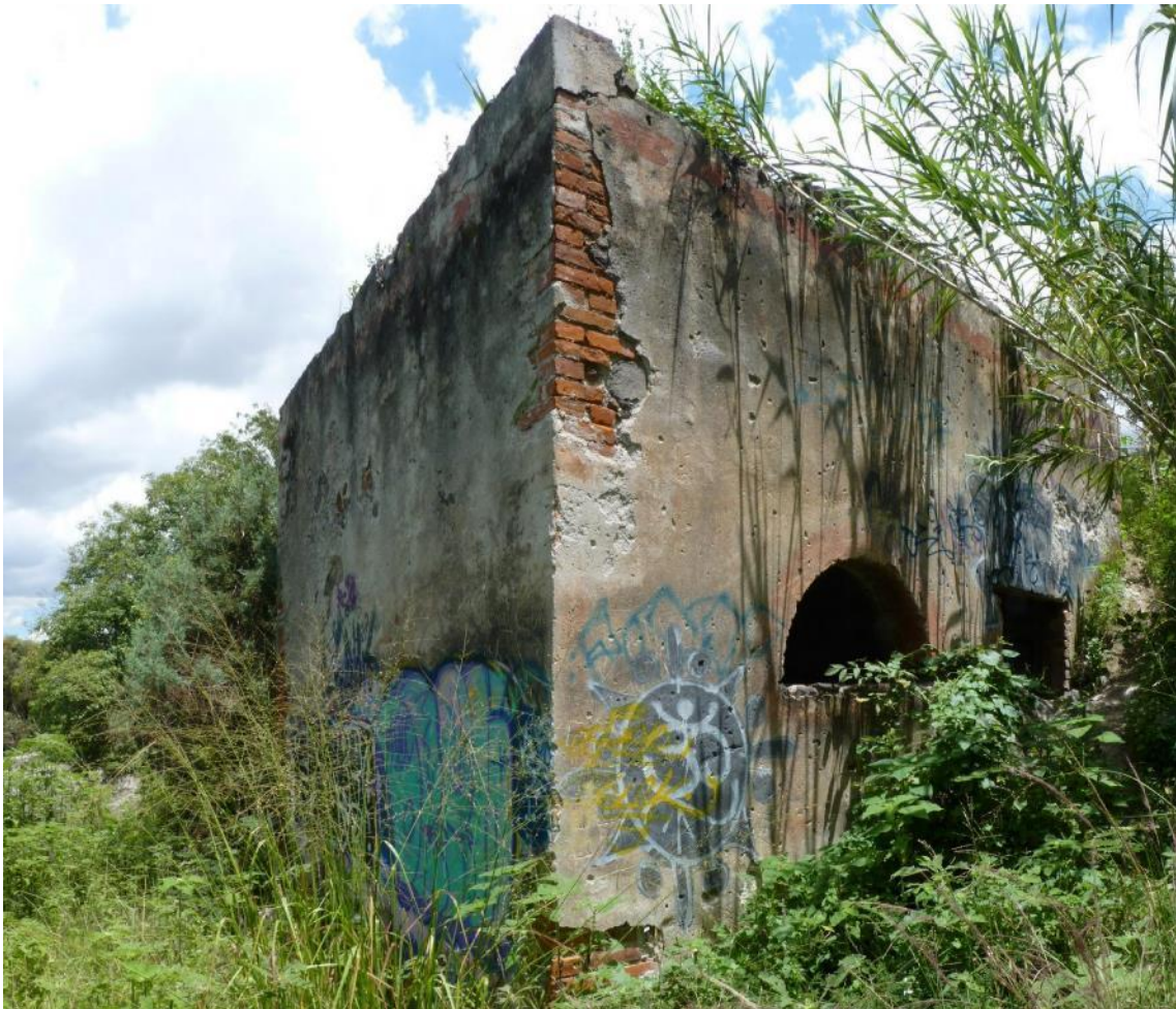
Figura 12. Caseta de las compuertas de ingreso al túnel, 2013. Fotografía del autor
