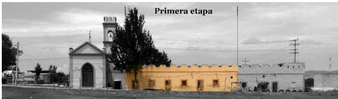
Figura 13. Vista del edificio de las casas para empleados y su capilla anexa, donde se indican las tres unidades de vivienda correspondientes a su primera etapa, 2014. Fotografía del autor
