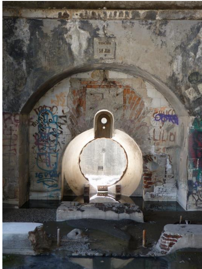
Figura 9. Vista del sitio donde estuvo instalada la turbina San Juan, 2012. Fotografía del autor
