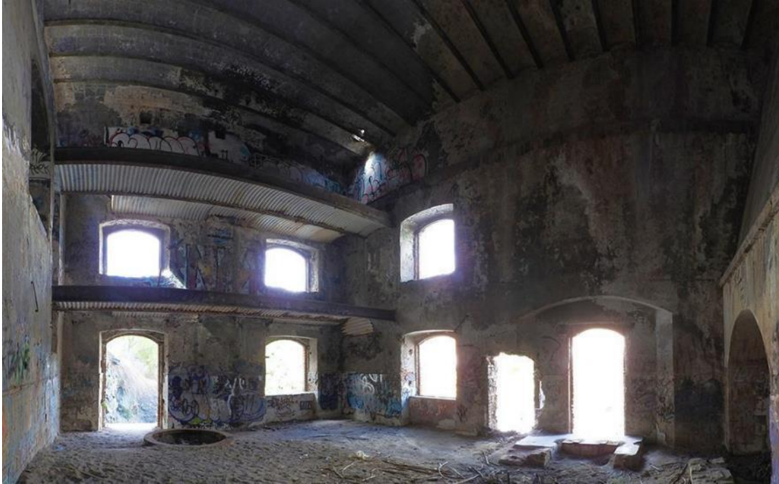
Figura 8. Vista interior de la casa de máquinas, 2023. Fotografía del autor
