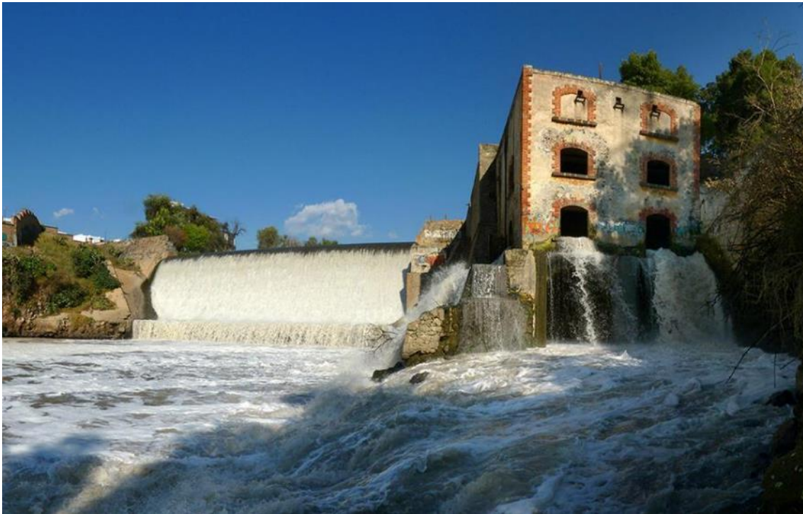
Figura 10. Vista exterior de la casa de máquinas durante la temporada de lluvias, 2014. Fotografía del autor
