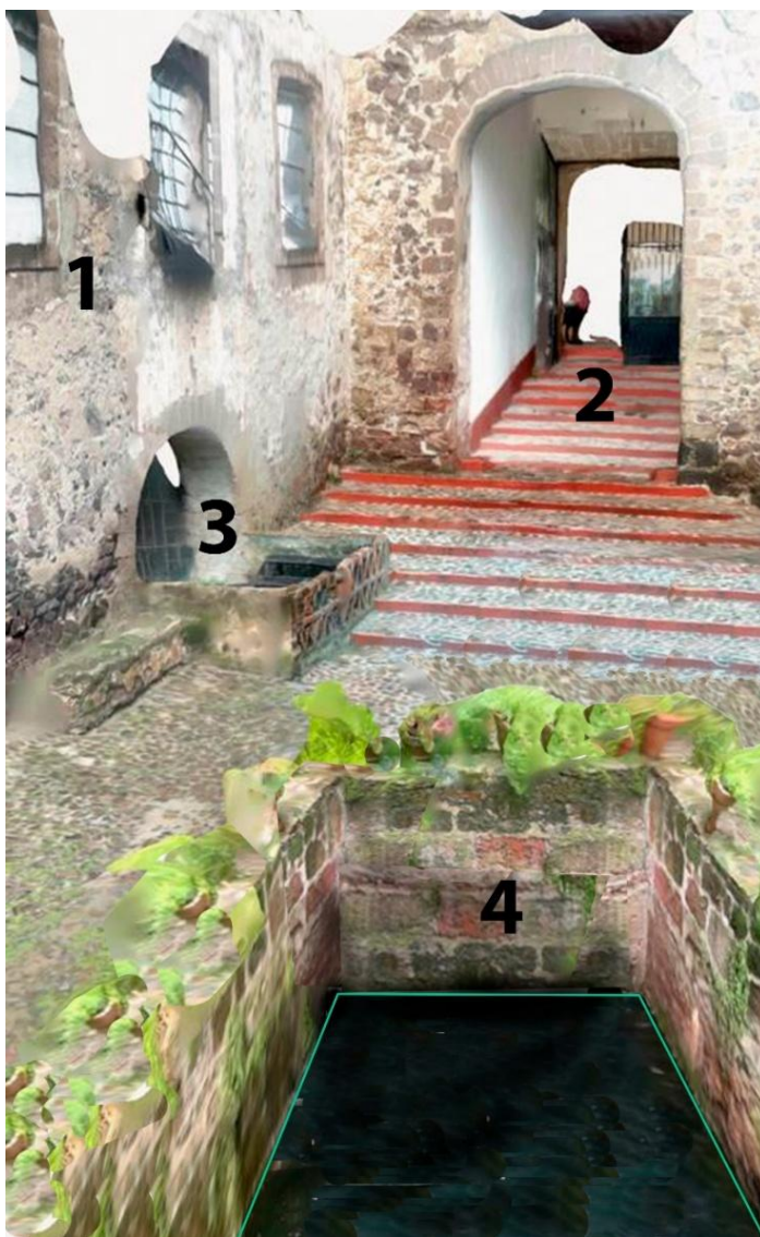
Figura 4. Levantamiento digital parcial del edificio de molienda (1), el acceso que conecta con el patio de casa grande (2), el cárcavo que alojaba las piedras de rodezno que se movían por el agua (3) y el canal de agua (4). Realización mediante PolyCam levantamiento LIDAR, con Iphone 15. Elaboración propia 2025
