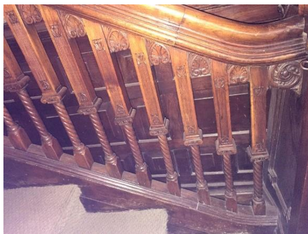
Figura 17. Detalle del barandal, se aprecian las balaustradas. Fotografía de la autora, 2017
