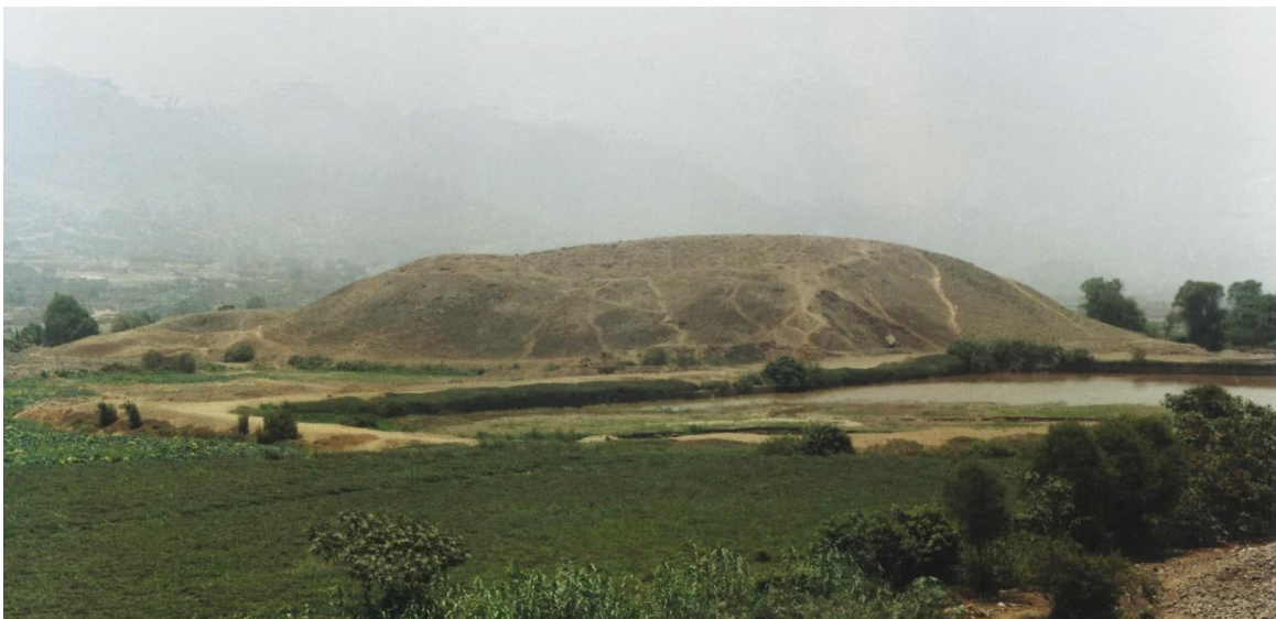
Figura 4. Edificación tronco piramidal central de Huacoy (fotografía: Edgar Quispe, 1999)
