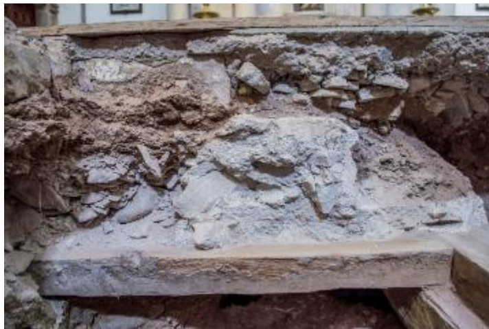
Figura 17. Sección del perfil Norte de la Unidad de excavación 1. Al centro puede observarse, sobre la viga de madera, un enlucido de cal y arena, así como la mampostería de lo que aparentemente es un escalón. Fotografía Alberto Peña
