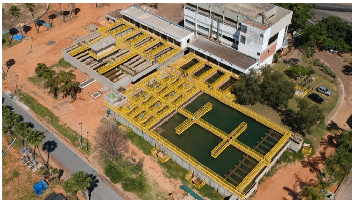
Figura A4. Ampliação e melhoria da ETA.
