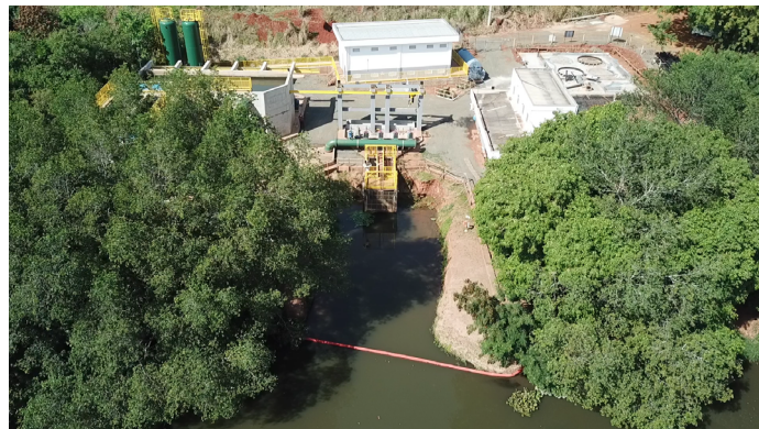
Figura A5. Ampliação da captação em Atibaia.
