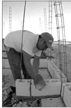
FIGURA 2. SUJECIÓN Y COLOCACIÓN DE BLOCK DE CONCRETO EN MURO EN PRIMERAS FILAS (SUJETO 2).
