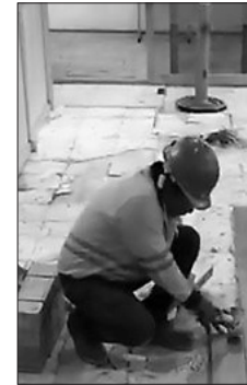
FIGURA 4. COLOCACIÓN DE PISO DE CERÁMICA (SUJETO 3).
