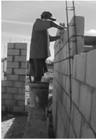
FIGURA 7. SUJECIÓN Y COLOCACIÓN DE BLOCK DE CONCRETO EN MURO EN FILAS SUPERIORES (SUJETO 2).
