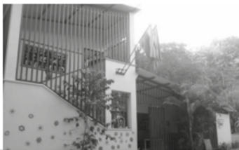
SEDE C – ESCUELA RURAL EL MANSITO
