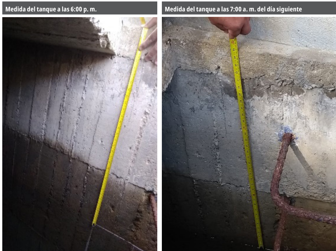
Figura 3. Medición de la pérdida de agua tratada
