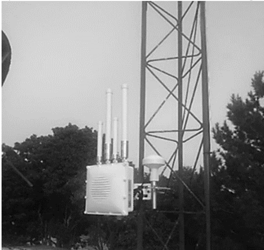
Figura 19. Montaje de Gateway 1 en Torre estructural TZ45 ubicada en Labcom 1.
