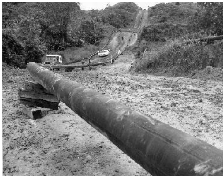
Construcción de un gasoducto tumbando bosque. Sogamoso-Cib. Agosto 1982. Foto cortesía de Ecopetrol.
