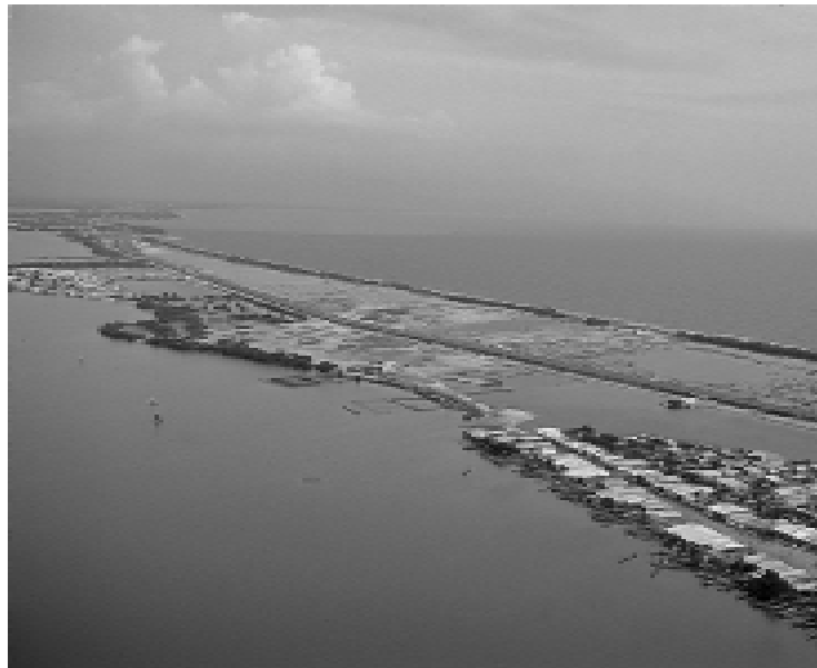
Carretera de La Cordialidad, que hizo colapsar el ecosistema. Lagos y lagunas de Colombia. Edición Banco de Occidente S.A. Foto: C. Gómez Durán
