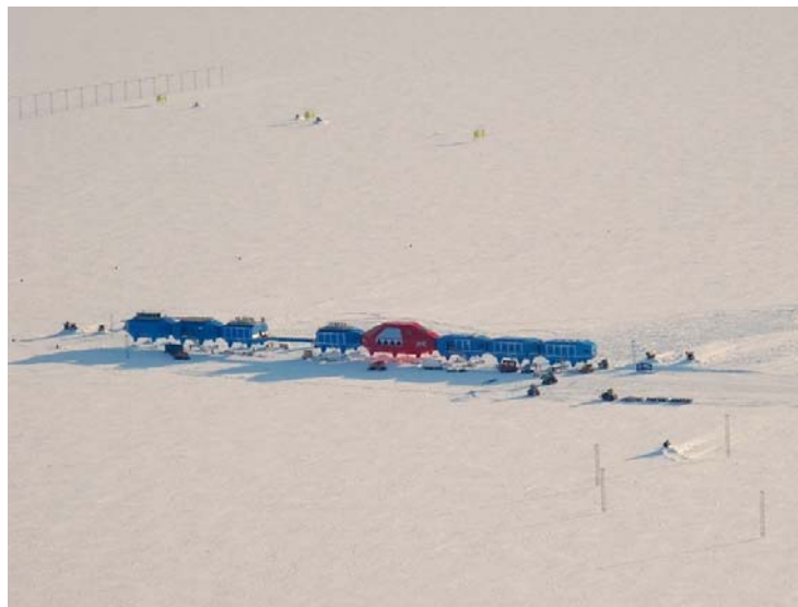
Figura. 16. Estación de investigación Halley VI en Antártica (de tipo auto-caravana con módulos apoyados sobre patas con esquíes), la cual aumenta su actividad en verano y la reduce en invierno
