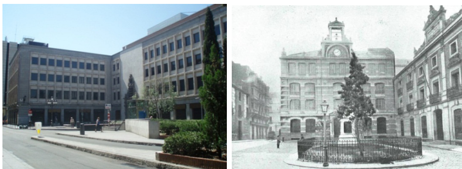
Imágenes 11 y 12. Plaza de las Descalzas Reales. Nuevo edificio de 1964 (izquierda) y el desaparecido del siglo XVIII (derecha)
