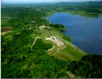
Figura 3. Presa Higuanojos, Sancti Spíritus, con deslizamientos en el talud aguas abajo, provocado por los agrietamientos primarios en el cuerpo de la cortina. (INRH, 2014).
