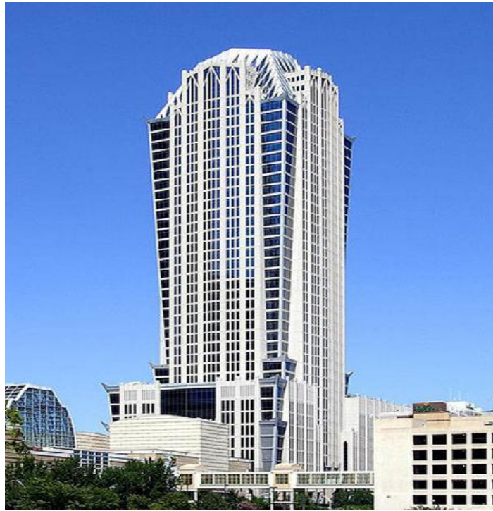
Figura 1. Torre prefabricada Hearst, uno de los edificios más altos de la ciudad de Charlotte en EUA.
